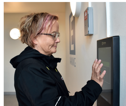
De nya fastigheterna har mer tekniska lösningar än de äldre beståndet till exempel digitala trapphustavlor där hyresgästerna kan boka bastu och tvättstuga.
